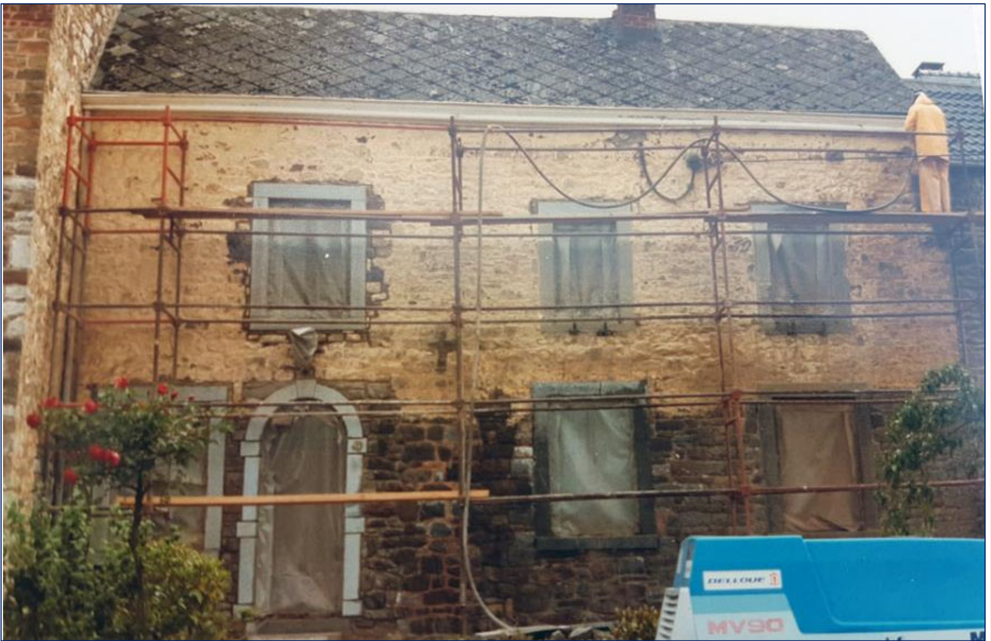
1979 - Pose de nouveaux encadrements aux ouvertures et sablage du mur de façade.
